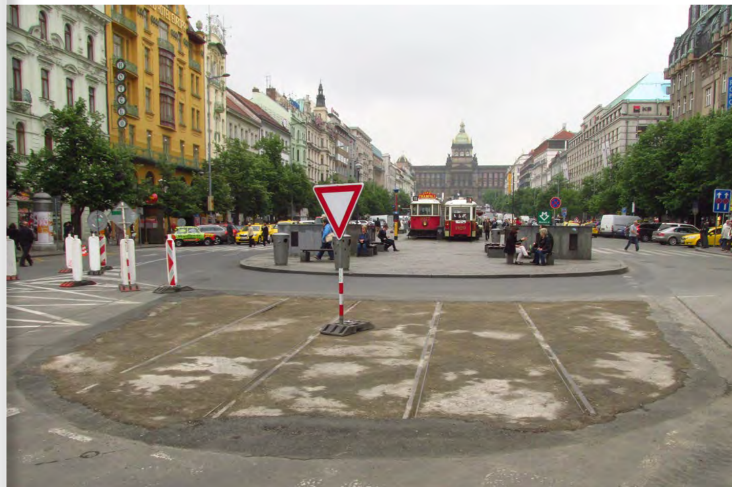
LIKVIDACE TRATĚ NEBYLA DŮSLEDNÁ. KROMĚ VÝCHODŮ Z METRA A KOMPLETNÍCH OBRYSŮ TĚLESA A ZASTÁVEK JSOU DOSUD SCHOVANÉ V BETONU KOLEJE NAD PODCHODEM V PŮLCE VÁCLAVÁKU. ODKRYTY BYLY 29. DUBNA 2014 FOTO: FILIP JÍŘEK
