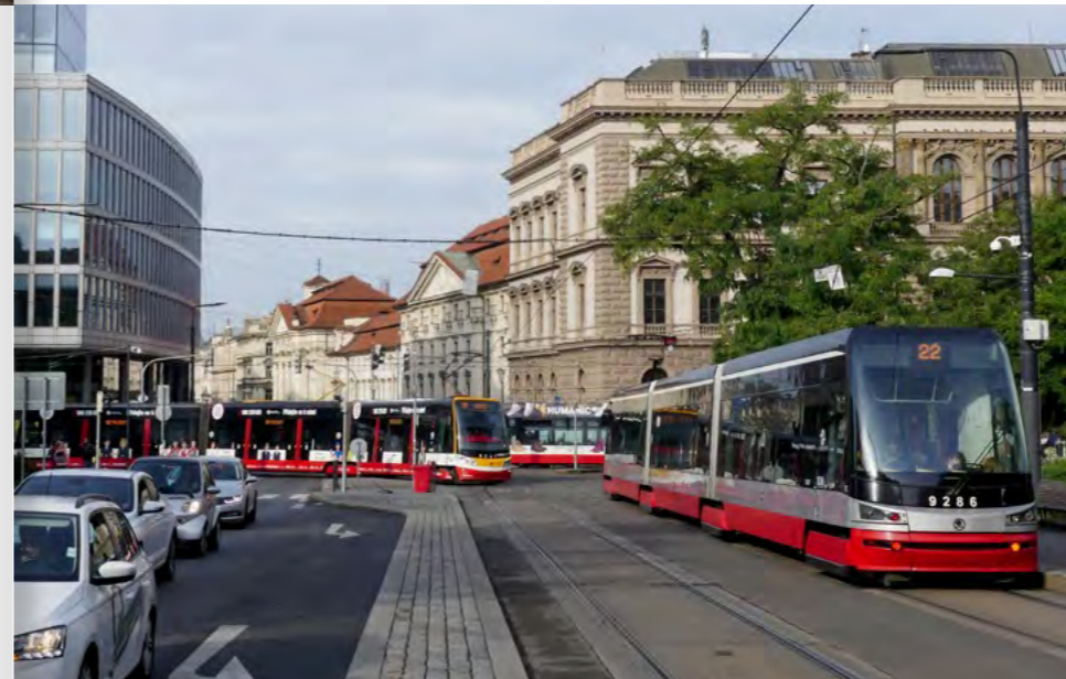
NEJZATÍŽENĚJŠÍ KŘIŽOVATKOU V PRAZE Z POHLEDU TRAMVAJÍ JE KARLOVO NÁMĚSTÍ – RESSLOVA. ZA HODINU TUDY VE ŠPIČCE PROJEDE 169 TRAMVAJOVÝCH SPOJŮ. V ROCE 2023, TŘI ROKY PO OBNOVĚ, BYLO SPUŠTĚNO DYNAMICKÉ ŘÍZENÍ BEZ PREFERENCE TRAMVAJÍ NAMÍSTO PEVNÉHO PROGRAMU S VÝZVOU PRO TRAMVAJE OD JEČNÉ VLEVO
