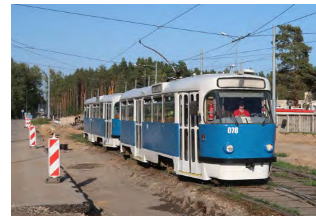
SOUPRAVA TRAMVAJÍ T3D VYJÍŽDÍ OD VOZOVNY. V POZADÍ JE PATRNÁ VÝSTAVBA NOVÉ TRATĚ
