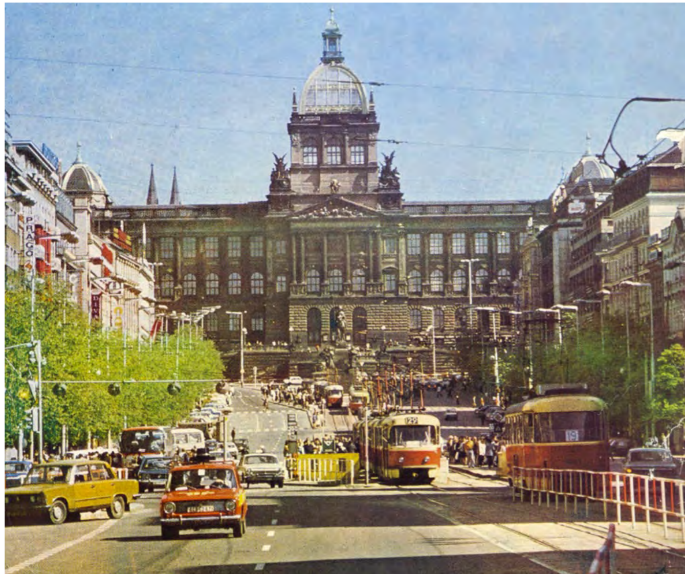
PRAVDĚPODOBĚNĚ V ČASOPISE PRAHA '80 VYŠEL TENTO ZDAŘILÝ SNÍMEK, KTERÝ UKAZUJE OBNOVENÉ NÁMĚSTÍ PLNÉ TRAMVAJÍ A DISPEČERSKÉHO ŽIGULÍKA DP. NAHORU JEDE NEOBVYKLE JEDNOVOZOVÝ VLAK NA LINCE 19, OVŠEM JE TO TEHDY NOVÁ TYRISTORKA. TENTO SNÍMEK JSEM RÁD DÁVAL DO PREZENTACÍ ZÁMĚRU OBNOVENÍ TRAMVAJOVÉHO PROVOZU NA VÁCLAVÁKU
