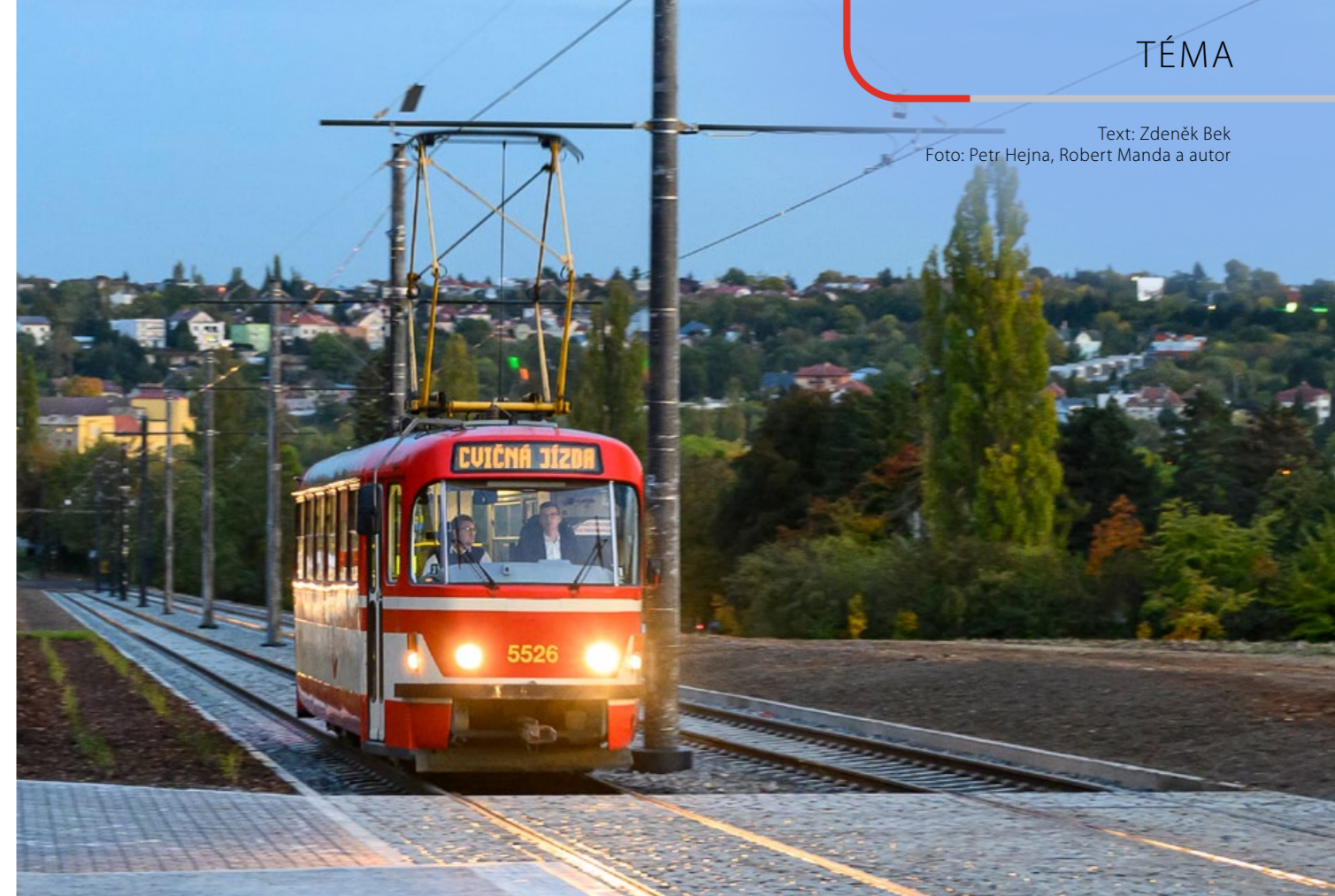
ÚSEK OD KŘÍŽOVATKY ULIC VLASTINA A DRNOVSKÁ DO KONEČNÉ ZASTÁVKY DĚDINA JE JEDINÝM MÍSTEM TRATĚ, KDE JE POVOLENA ŠEDESÁTIKILOMETROVÁ RYCHLOST
