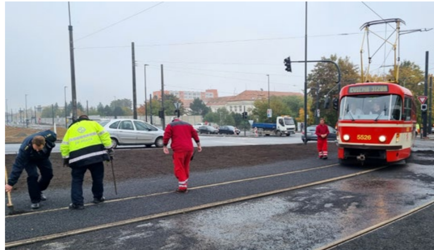
PRVNÍ JÍZDY SE KONALY JEŠTĚ PŘED OFICIÁLNÍM OTEVŘENÍM TRATI. PRŮJEZD CVIČNÉ TRAMVAJE TAK BYL PRO PRACUJÍCÍ DÉLNÍKY PŘEKVAPENÍM. NA SNÍMKU TAK S OČISTOU KOLEJÍ POMAHAJÍ I DISPEČERÍ DPP
