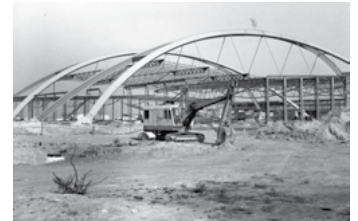
PODLE NOVÉHO PROJEKTU JE NA ŠIKMÝCH OBLOUCÍCH ZAVĚŠENA NEJEN VLASTNÍ STŘECHA, ALE I BOČNÍ STĚNY HALY
