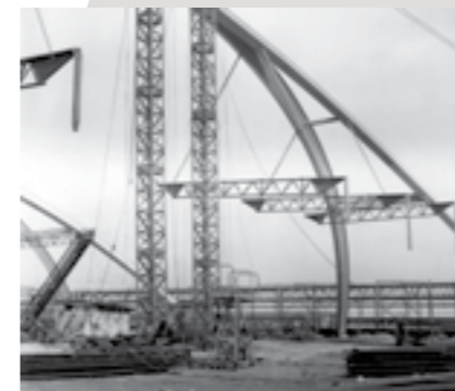
VÝSTAVBA ŠIKMÝCH OCELOVÝCH OBLOUKŮ STŘEŠNÍ KONSTRUKCE PODLE PROJEKTU ING. JOSEFA ZEMANA
