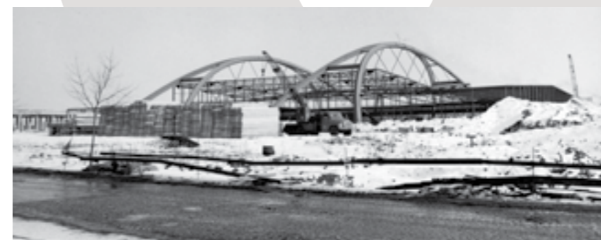
HRUBÁ STAVBA GARÁŽOVACÍ HALY V BŘEZNU 1970
