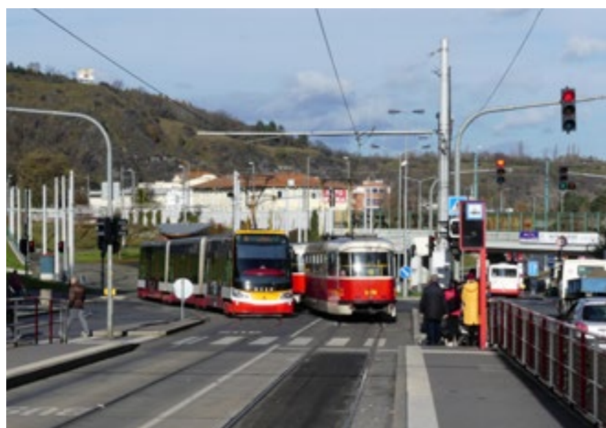
PREFERENCE TRAMVAJÍ BYLA ROVNĚŽ ZAVEDENA NA SSZ PODBABSKÁ – VE STRUHÁCH. TRAMVAJÍM, KTERÉ VYJÍŽDĚJÍ SE SMYČKY NÁDRAŽÍ PODBABA, SE SNÍŽILO RIZIKO, ŽE NESTIHNOU VÝJEZD Z NÁSTUPNÍ ZASTÁVKY VE STANOVENÝ ČAS
