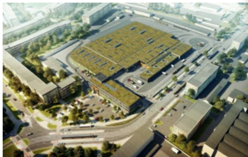
PROJEKT REKONSTRUKCE VOZOVNY SLOVANY V PLZNI ZÍSKAL PRVNÍ MÍSTO V KATEGORII NEJLEPŠÍ STAVBY NAD 50 MIL. EUR
