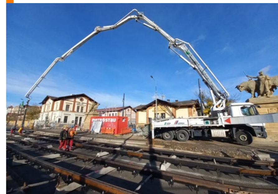
BETONÁŽ PROBÍHAJÍCÍ PŘED HOLEŠOVICKOU TRŽNICÍ
