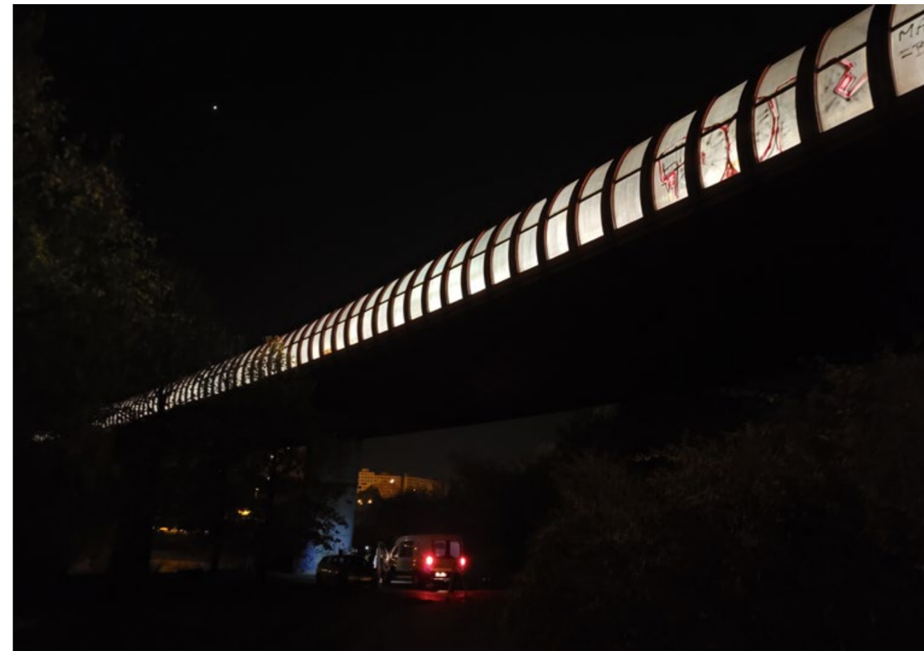
VÝSLEDKY MĚŘENÍ STAVU MOSTU BUDOU ZNÁMY KONCEM ROKU 2023
