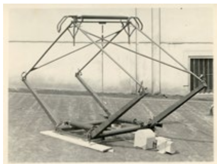
UPRAVENÝ PANTOGRAF SP36 PRO PROTOTYP T3 Č. 6101 DISPOVOVAL S ELEKTRICKÝM OVLÁDÁNÍM, KTERÉ SE V POZMĚNĚNÉ PODOBĚ DOSTALO I NA SÉRIOVÉ VOZY T3. SHODNÝ SBĚRAČ, ALE S RUČNÍM OVLÁDÁNÍM, BYL POUŽIT I PRO ZKUŠEBNÍ VOZY T1 Č. 5091 A 5126. KVŮLI NÍZKÉ SPOLEHLIVOSTI NĚKTERÝCH KOMPONENT SE ELEKTRICKÉ OVLÁDÁNÍ NEUJALO A POZDĚJI SE PŘEŠLO ZPĚT K RUČNÍMU OVLÁDÁNÍ S MECHANICKÝM BUBNEM NA STŘEŠE OVLÁDANÝM PROVAZEM ZAKONČENÝM TYPICKOU DŘEVĚNOU HRUŠKOU NA STANOVIŠTI ŘIDIČE FOTO: SBÍRKA IVANA RÁDLA
