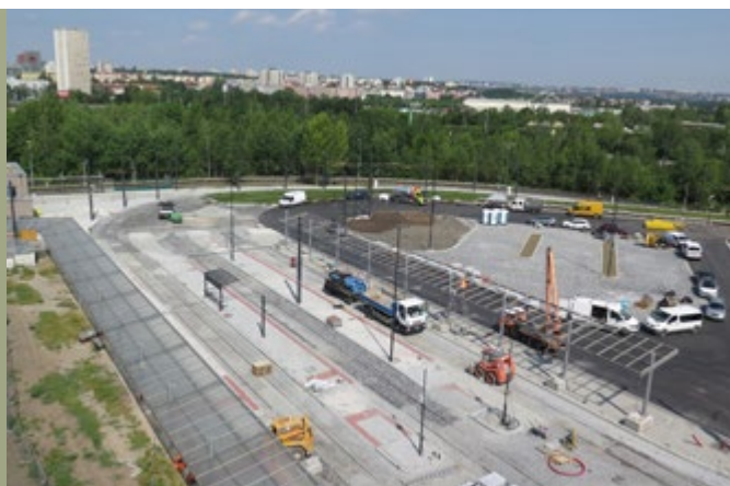
ZÁVĚR PRACÍ V ČERVENCÍ 2022
