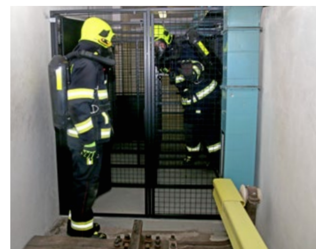
PRŮCHOD PŘES NOVÝ KLECOVÝ SYSTÉM S KOLEJÍSTĚM
