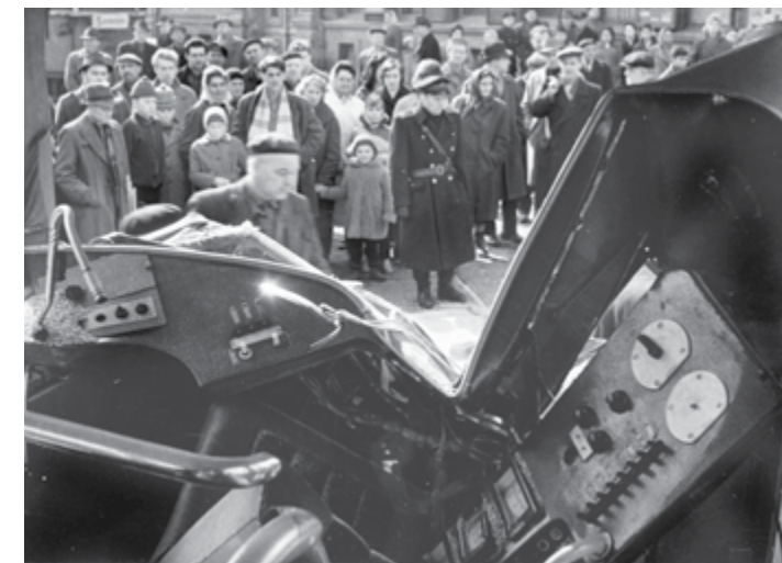
INTERIÉR PROTOTYPU T3 Č. 6101 S UMĚLOU ZÁTĚŽÍ ZASYPANOU SLADOVNICKÝM JEČMENEM, 8. 3. 1962 FOTO: PAVEL NEJEPSA
