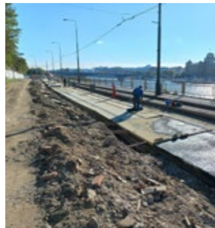
PRÁCE DODAVATELE TSK NA IZOLACI NÁBREŽNÍ ZDI. PŮVODNĚ SE S NIMI NEPOČÍTALO
