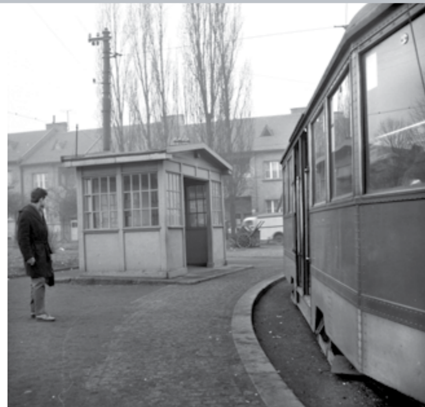
PRAKTICKY PO CELOU DOBU EXISTENCE SMYČKY STÁLA NA KONEČNÉ DŘEVĚNÁ ČEKÁRNA. TATO FOTOGRAFIE BYLA POŘÍZENÁ NĚKDY MEZI LÉTY 1961 A 1964
