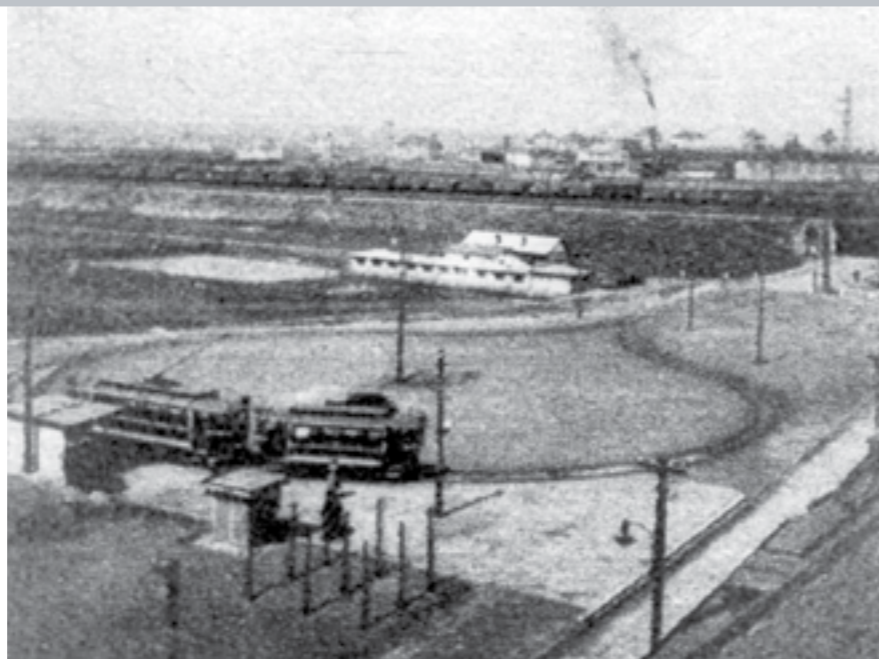
ZE SBÍRKY KARLA DUŠÁNKA POCHÁZÍ NEDATOVANÁ REPRODUKCE Z NEZNÁMÉHO ČASOPISU, SNAD Z ROKU 1937, NA NÍŽ JE DOBRĚ VIDĚT PŮVODNÍ KRUHOVITÝ TVAR KOLEJOVÉ SMYČKY
