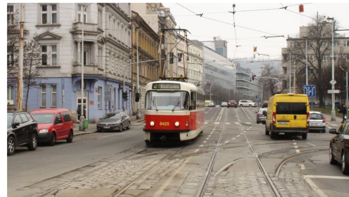
VÝMĚNY VÝHYBEK BYLY VYJMUTY V NOCI Z 2. NA 3. BŘEZNA 2021, ZAVARENY JSOU I SRDČOVKY PRO JÍZDU PŘÍMÝM SMĚREM
