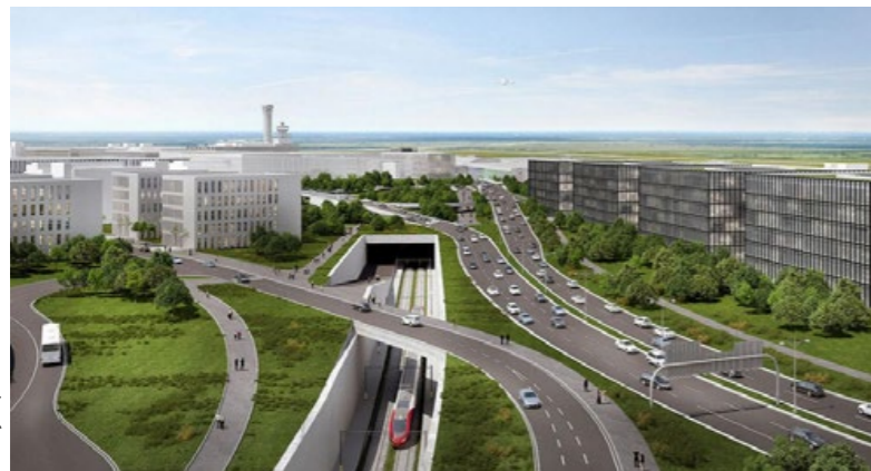
Zdroj: Správa železnic
