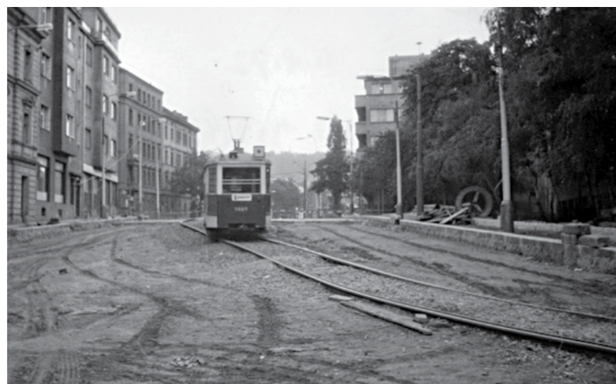
PŘESTAVBA KŘIŽOVATKY RADLICKÁ – ZA ŽENSKÝMI DOMOVY A JEJÍ JEDNOKOLEJNÁ ETAPA BYLA ZDOKUMENTOVÁNA JIŘÍM ČERMÁKEM 4. SRPNA 1971
