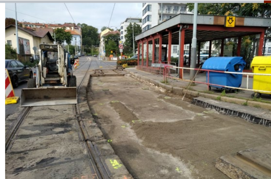
HAVARIJNÍ OPRAVA ZCELA ROZBITÝCH PANELOVÝCH PROTIoblouků BYLA ZVĚČNĚNA 27. SRPNA 2019
