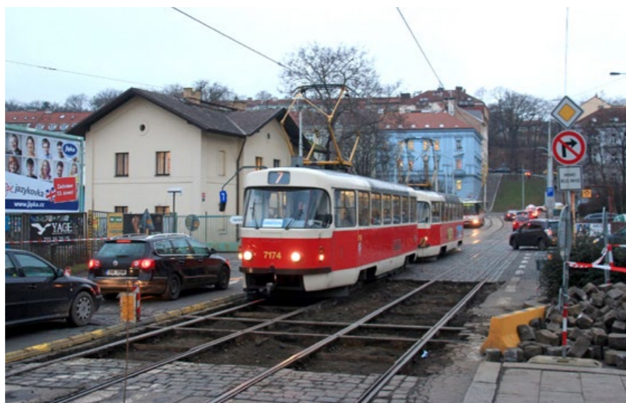
MICHAL VÁŇA POŘÍDIL 19. LEDNA 2015 I SNÍMEK PŘÍPRAVY LIKVIDACE ZBYLÉHO KŘÍŽENÍ S VLEČKOU
