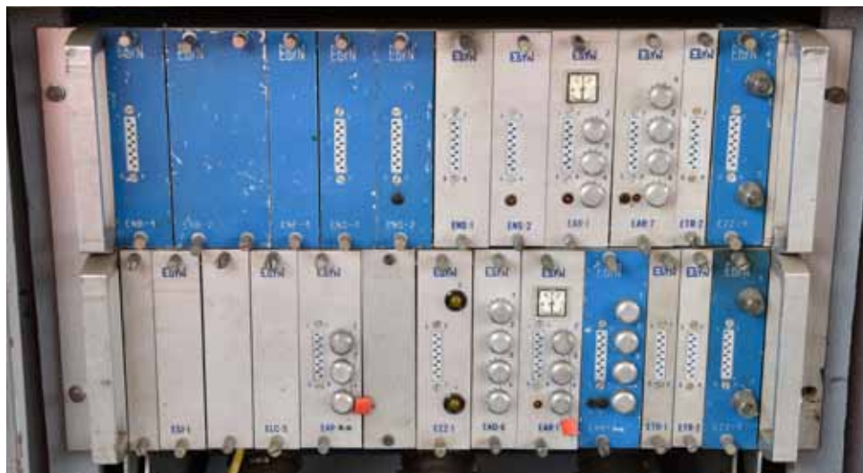
Elektronický regulátor tyristorové pulzní regulace TV1.
