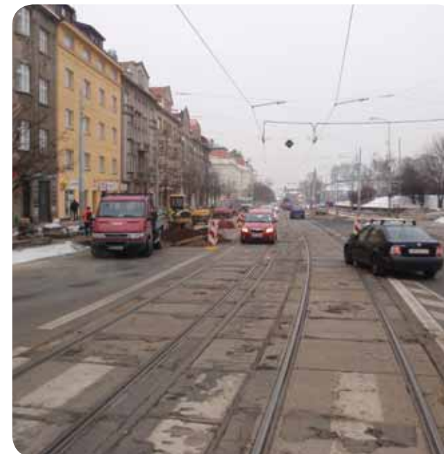
Během lednových mrazů bylo zahájeno budování objízdňé trasy.
