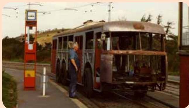
Kromě opravy kostry vozu jsme ve Vokovicích stačili ještě provést celkovou opravu řízení, pérování a brzd. Zkušební jízdy jsme uskutečnili mezi vozovnou Vokovice a Divokou Šárkou v srpnu 1992, těsně před stěhováním muzea do Střešovic. Foto: L. Vidím
