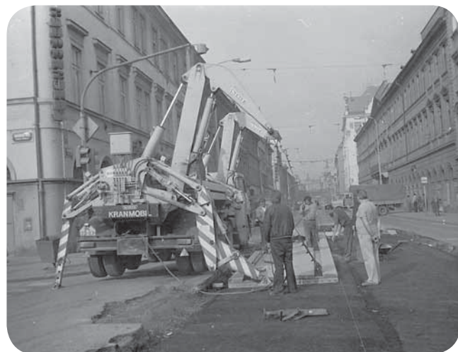
V prvopočátcích byly panely ukládány přepravníkem na kontejnery (bočním překladačem KLAUS). Karlínské náměstí, rok 1979. Foto: archiv JDCT
