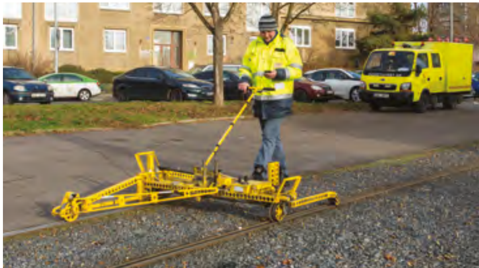
VOZÍK KRAB PŘI MĚŘENÍ HODNOT GEOMETRICKÉ POLOHY KOLEJNICE
