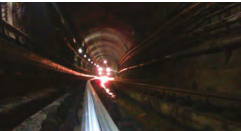
POHLED NA PRÁVĚ PŘEBROUŠENÝ ÚSEK KOLEJNICE
