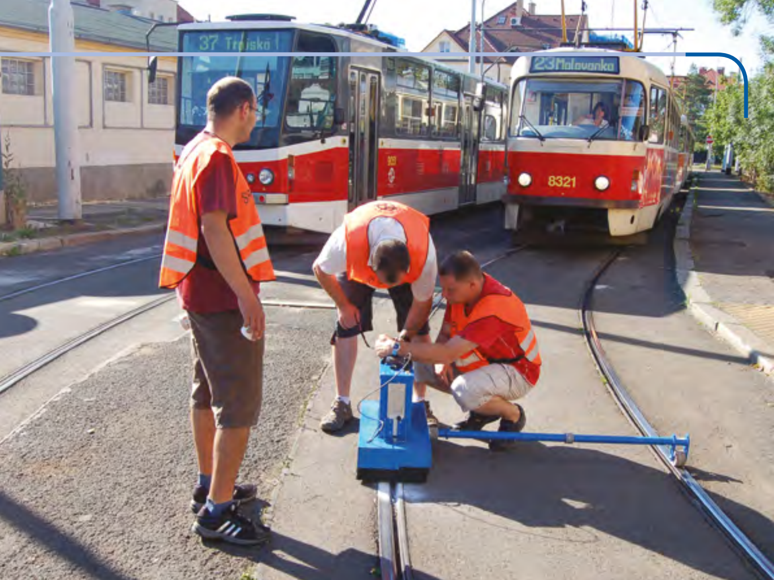
MĚŘENÍ PŘÍČNÉHO PROFILU KOLEJNICE LASEROVÝM PROFILOMĚREM KONTURA
